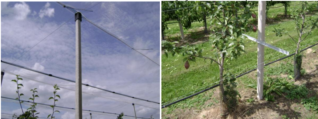
Figuur 12: Stevige betonnen palen om de constructie te dragen, de palen zijn voorzien van een juk
